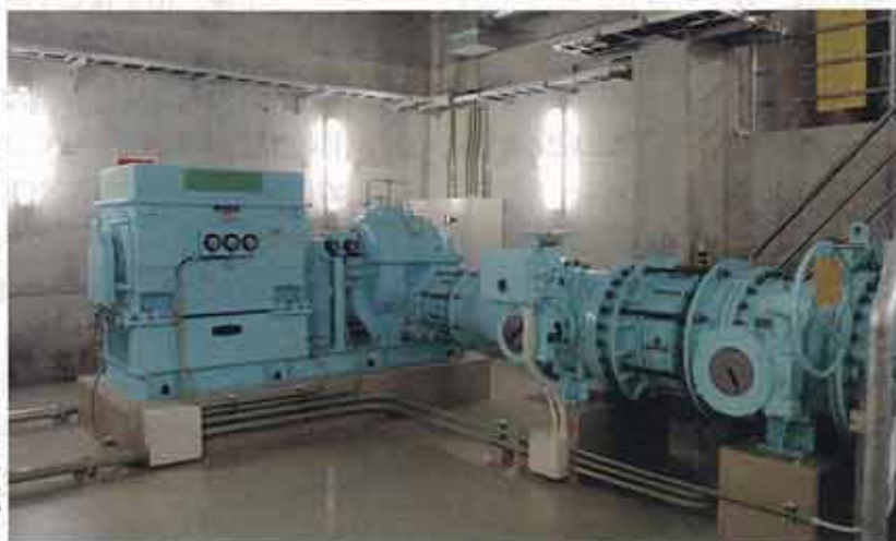
内閣府沖縄総合事務局が沖縄県大宜味村で整備中の大保(たいほ)ダムに設けた管理事務所などで使う電力の発電所(上)とその内部(右)。ニュージェックが発電施設の構造設計を担当した。発電所の最大出力は370kW(写真:2点ともニュージェック)
